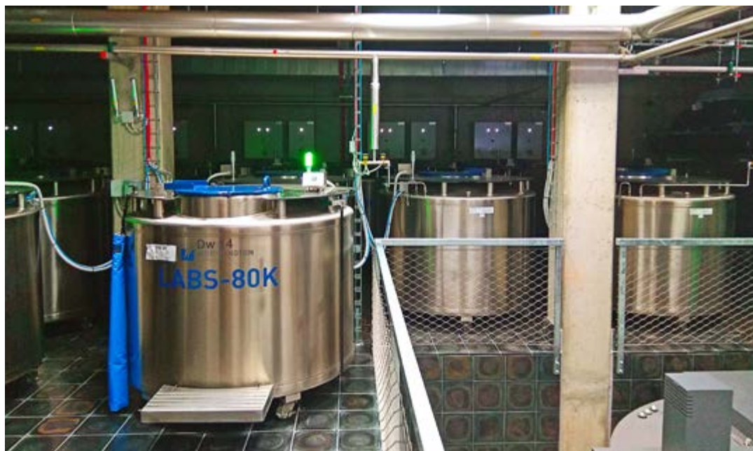
V suterénních prostorách Ústavu hematologie a krevní transfuze v Praze se nachází kryosklad, v němž se uchovávají krevní deriváty, vzorky a další látky při teplotách nižších než -150^{\circ}\text{C} .
