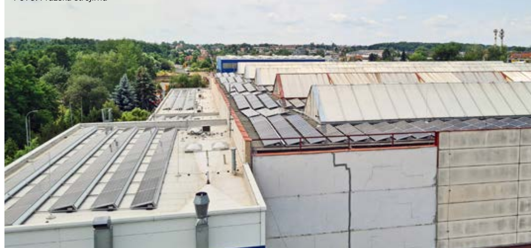
Pražská strojírna nedávno instalovala 2200 panelů s jmenovitým výkonem 450 Wp.
